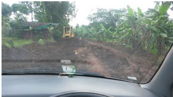
Onze opengebroken toegangsweg
